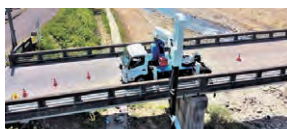
当社橋梁点検車使用による点検
