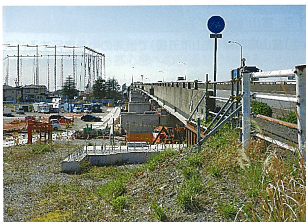
富山跨線橋ランプ橋付近
