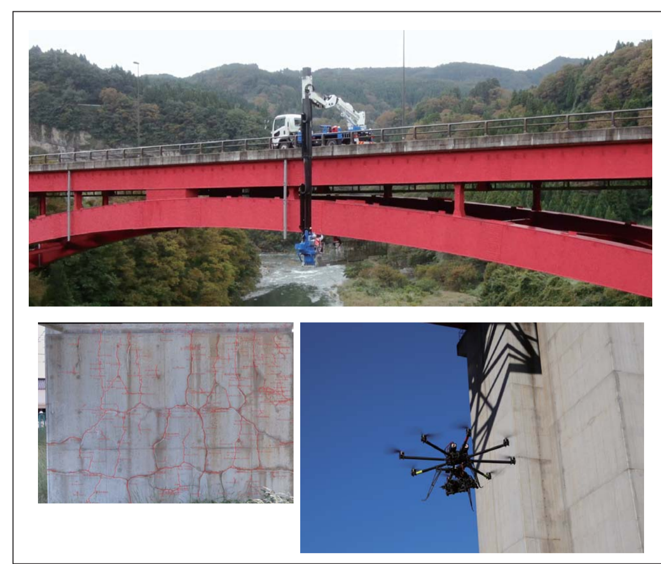
点検ロボット活用による橋梁点検の効率化
