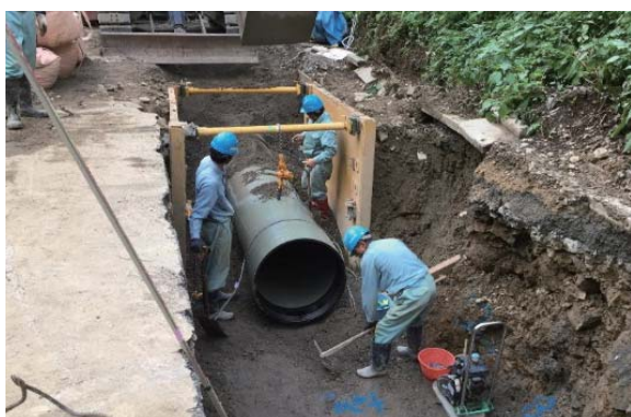
埋設管施工中の状況
