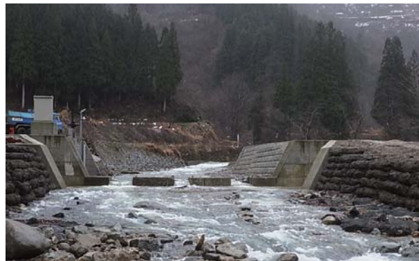
取水堰堤（下→上）
