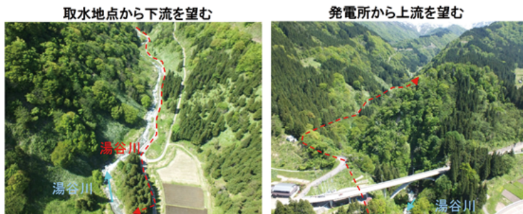
発電所位置鳥瞰写真
