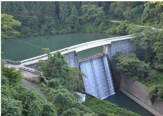
写真-1 平沢川砂防堰堤
