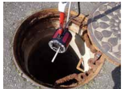
管口カメラによる点検(中核市実績)
