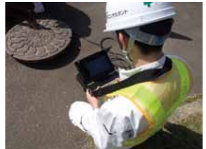
管口カメラによる点検(中核市実績)
