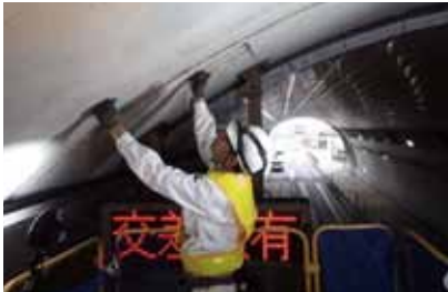
トンネル定期点検（県実績）
