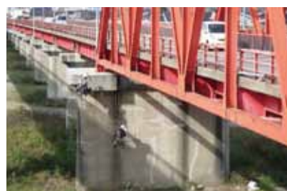
ロープワークによる橋梁定期点検（県実績）
