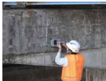
橋梁詳細調査（市実績）
