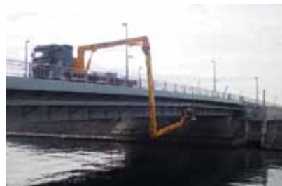
BT-400相当の橋梁点検車使用による点検
