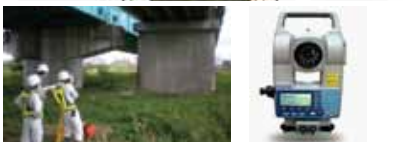
KUMONOSを使用したひび割れ計測
