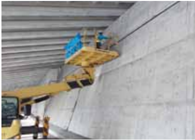
シェッド定期点検（県実績）
