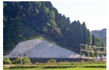
斜面崩壊 法面対策工設計(県実績)
