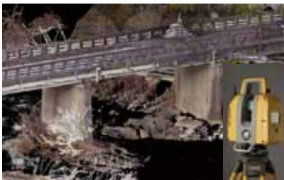
3Dレーザスキャナによる3次元測量 (市実績)
