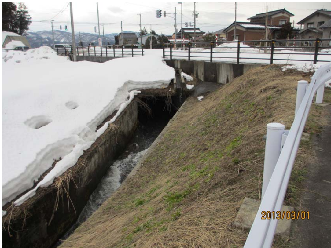
図Ⅱ－５（２） 栃津川合流点上流の急流工（落差約 1.5m）の写真
