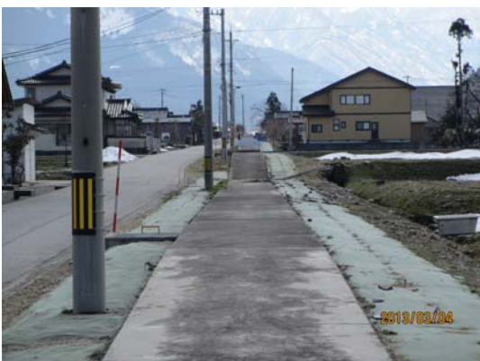
④暗渠部・・暗渠内に落差工（落差不明）
