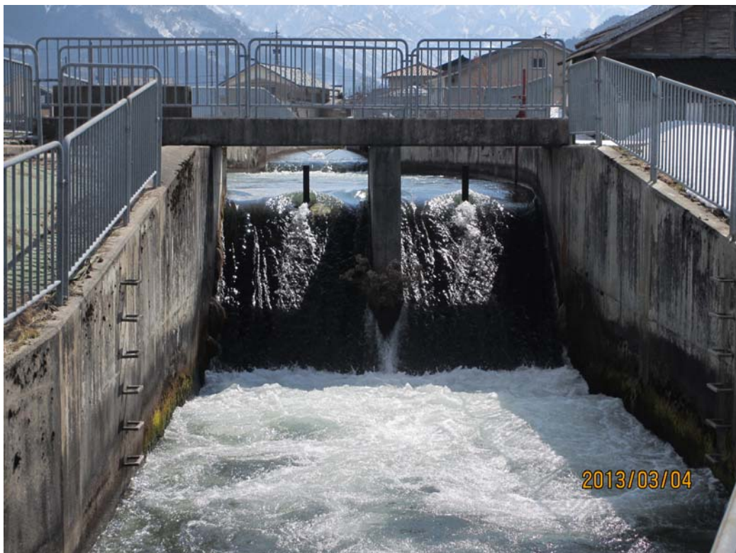
図Ⅱ－４（２） 分水工（落差約1.5m）の写真
