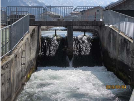
①分水工（落差約1.5m）
