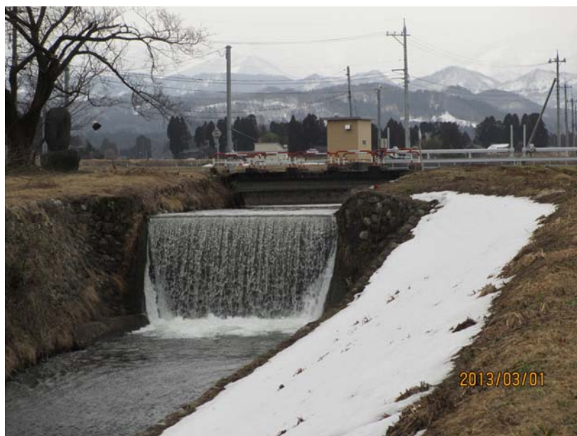
図Ⅱ－6（2） 仁右衛門分水下流の落差工（落差約2.4m）の写真
