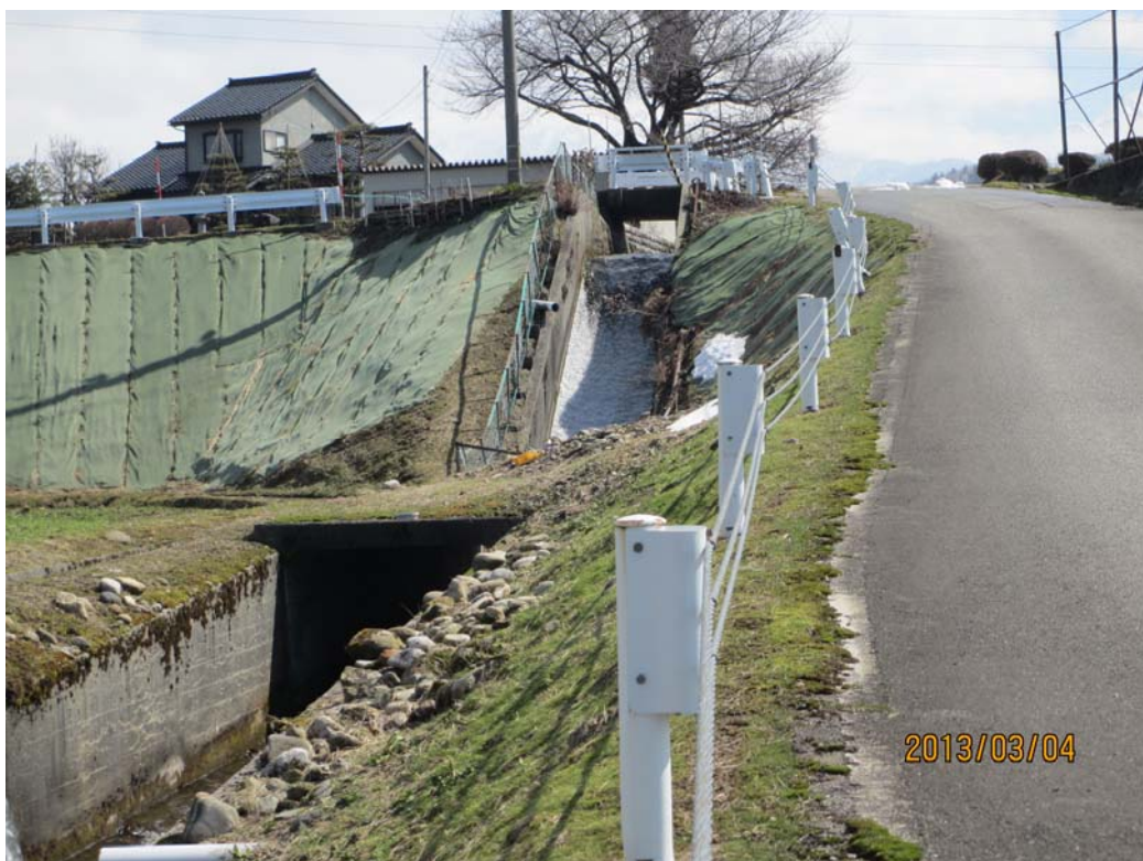
図Ⅱ-3（2） 荒井排水路急流工（落差約5.7m）の写真
