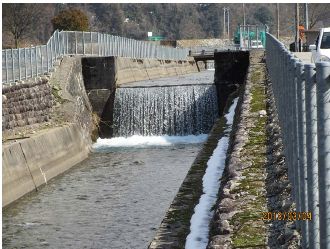
図Ⅱ-7(2) 導水路二区終点の落差工(落差約1.9m)の写真
