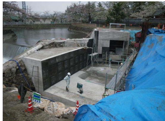
写真 1 発電所施工状況 (4 月末)
